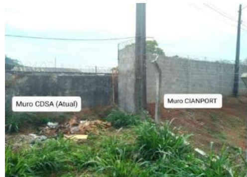
Situação do Muro existente
